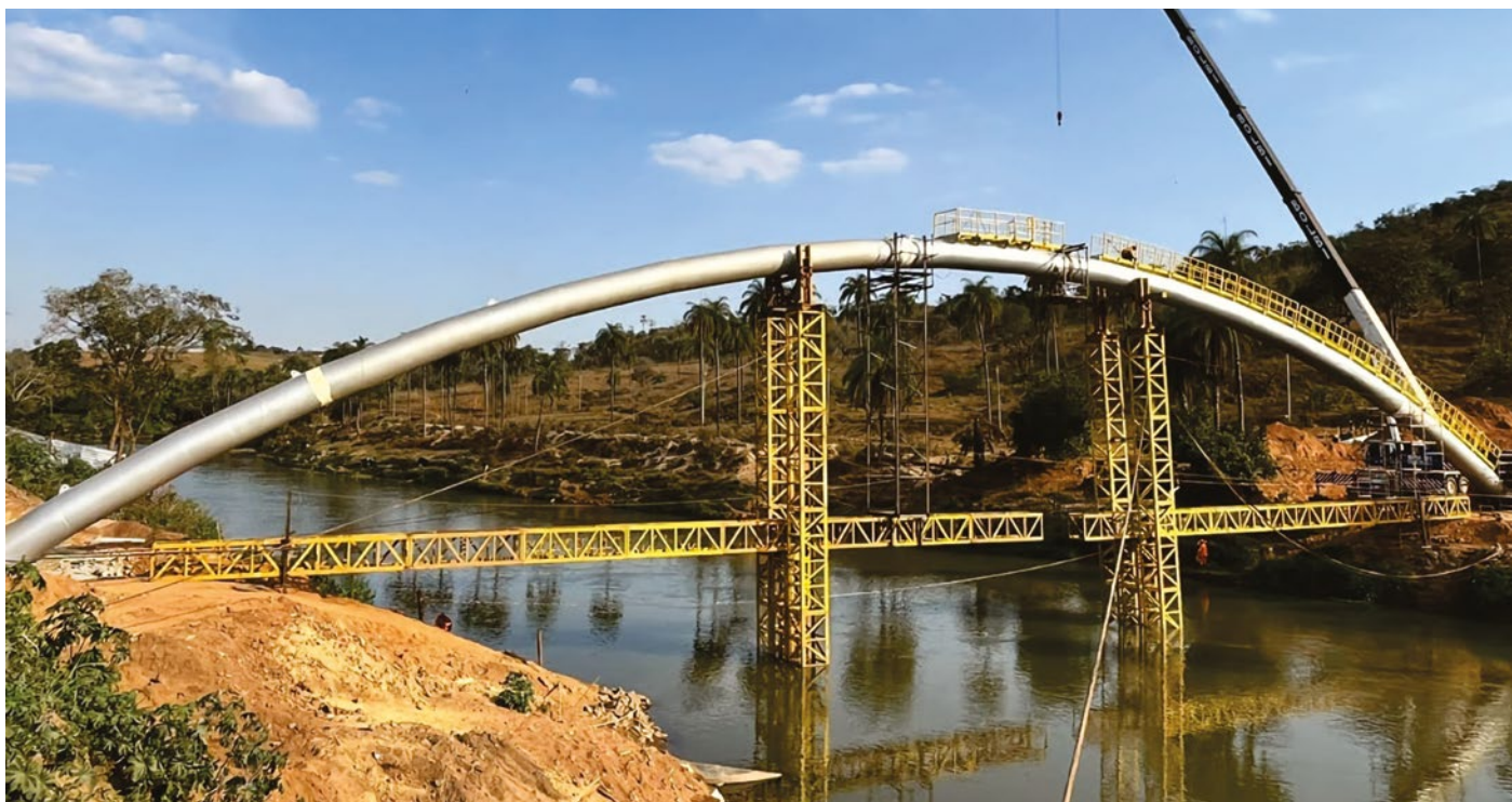
Travessia sobre Rio Paraopeba - Betim - MG
