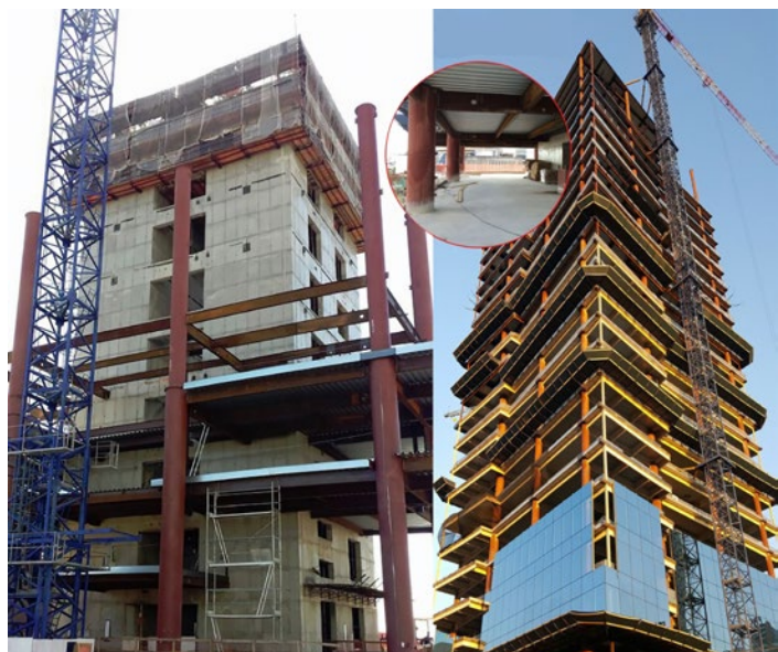
Edifício Concórdia Corporate Nova Lima - MG
