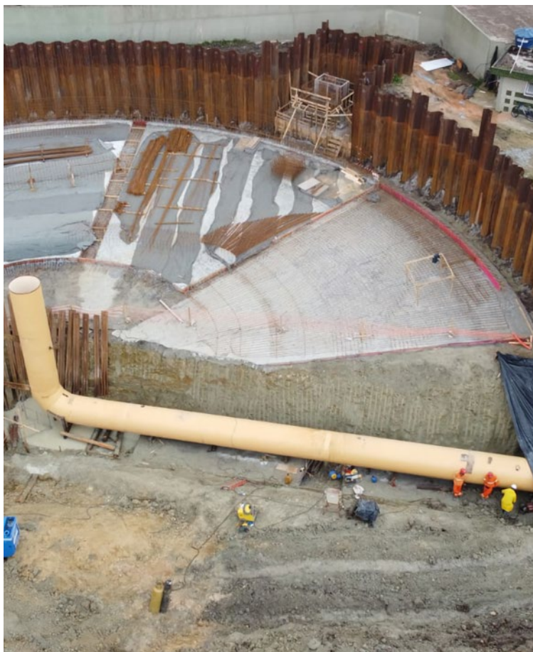
ETE Atuba Sul - Curitiba - PR
